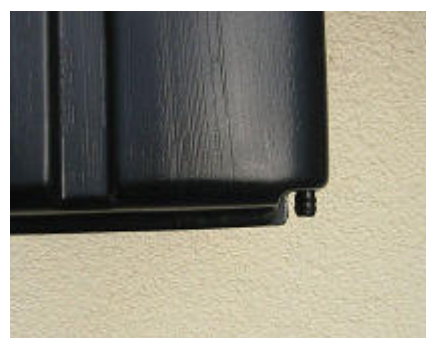
Detail spodní části nádržky. Vpravo dole je možné připojení z nádržky přímo do kanalizace.
